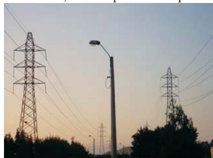
Ampliación alumbrado público, calle Las Salinas, La Greda. Monto de inversión $10.430.000
