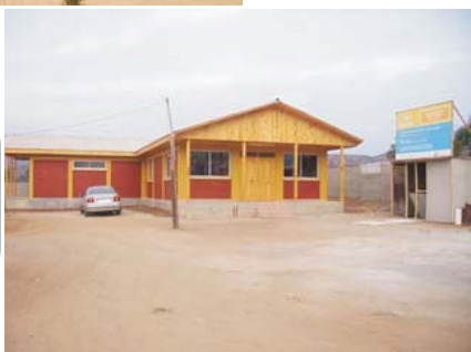
Construcción sede multipropósito Población Don Alfredo, Puchuncaví Monto de inversión $27.608.000
